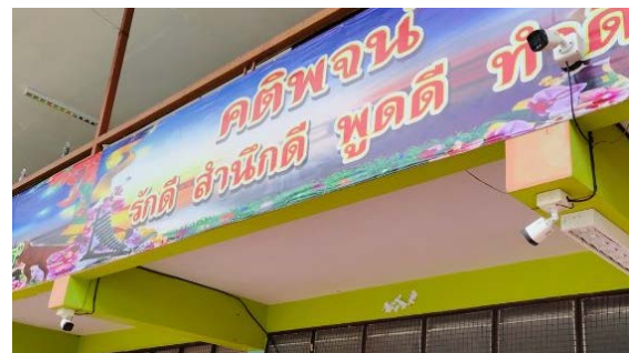
ติดตั้งกล้องวงจรปิดเพื่อความปลอดภัย
